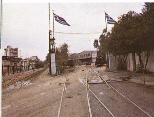
Αποψη των μηχανεργοστασίων του ΟΣΕ, όπως είναι σήμερα
