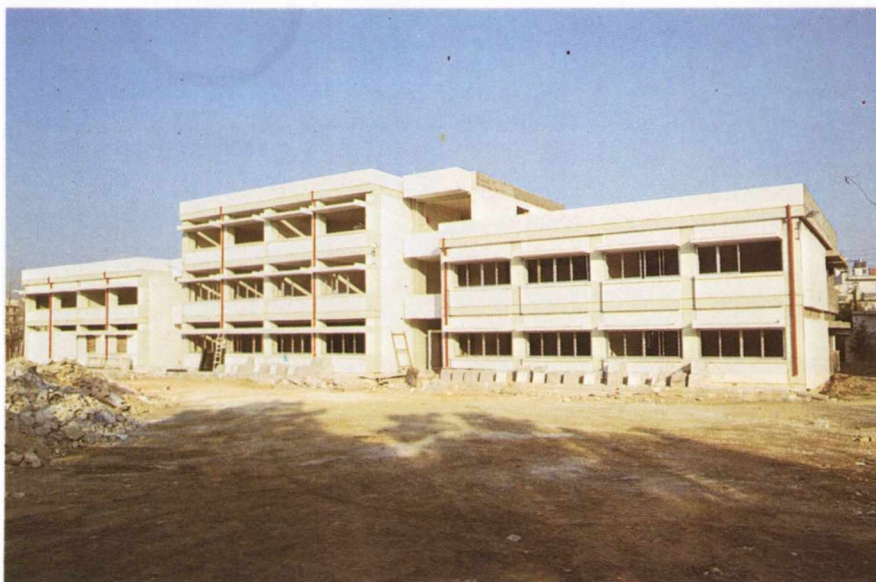
Το υπό κατασκευή 17ο Δημ. Σχολείο
