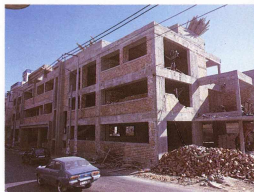
Το υπό κατασκευή 27ο Δημ. Σχολείο
