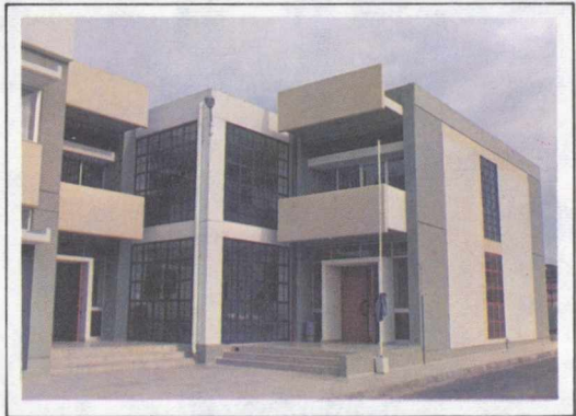
4ο Δημοτικό Μεταμόρφωσης
