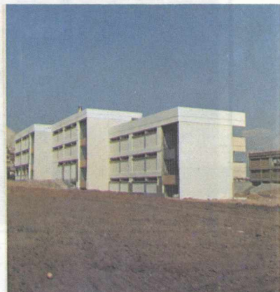
Εργοτάξιο Συγκρότημα Κορυδαλλού
