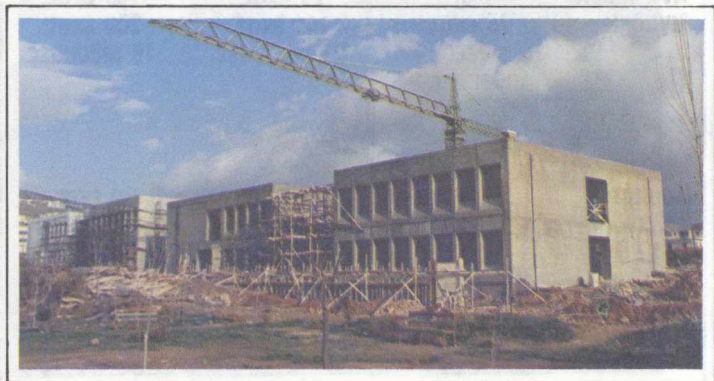
Εργοτάξιο - 11 Γυμνάσιο - Λύκειο Αγ. Ιερόθεου
