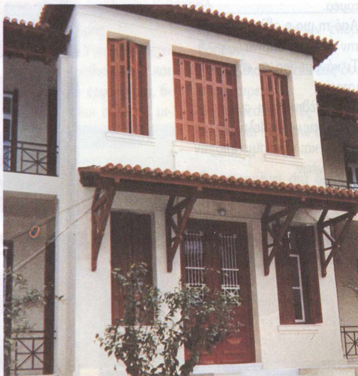
ΑΝΑΚΑΙΝΙΣΗ ΚΤΙΡΙΟΥ Ν.Ν.Θ.Α. (ΣΩΤΗΡΙΑ)
