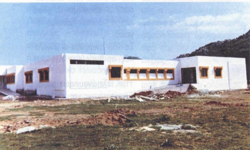
ΚΕΝΤΡΟ ΥΓΕΙΑΣ ΥΠΟ ΚΑΤΑΣΚΕΥΗ
