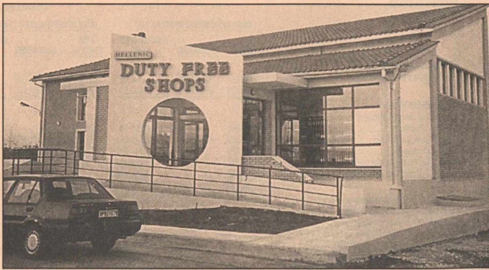
Στη γειτνίαση της Ελλάδας με τρίτες χώρες εκτός Ε.Ε. επενδύουν τα ελληνικά ΚΑΕ τις προσδοκίες τους για επιβίωση μετά την κατάργηση των ενδοκοινοτικών αφορολόγητων πωλήσεων.
