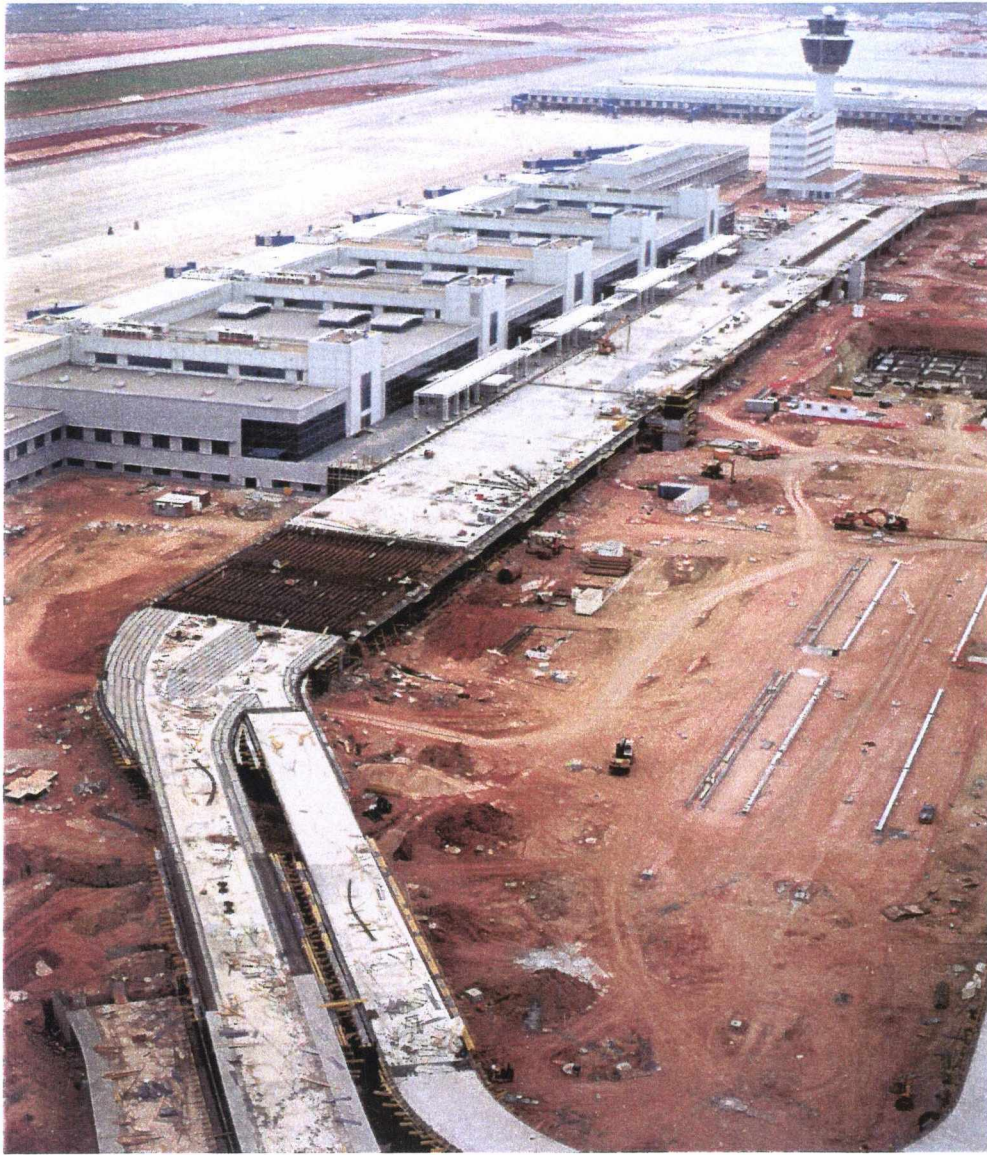
Κτίριο Κεντρικού Αεροσταθμού - Δυτική πλευρά
