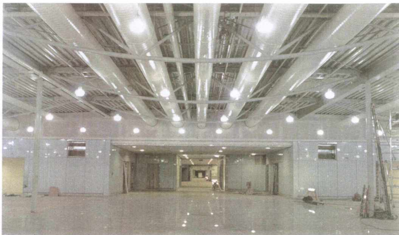
Εσωτερικοί χώροι / Κτίριο Κεντρικού Αεροσταθμού
