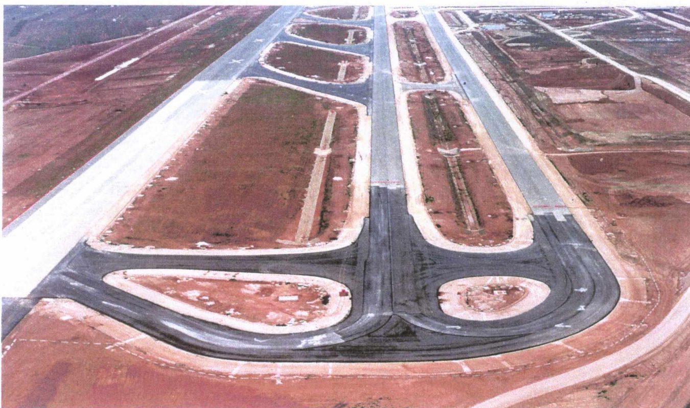
Δυτικός Διάδρομος Αποπροσγείωσης
