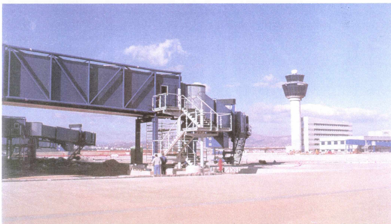
Γέφυρα Επιβίβασης Επιβατών
