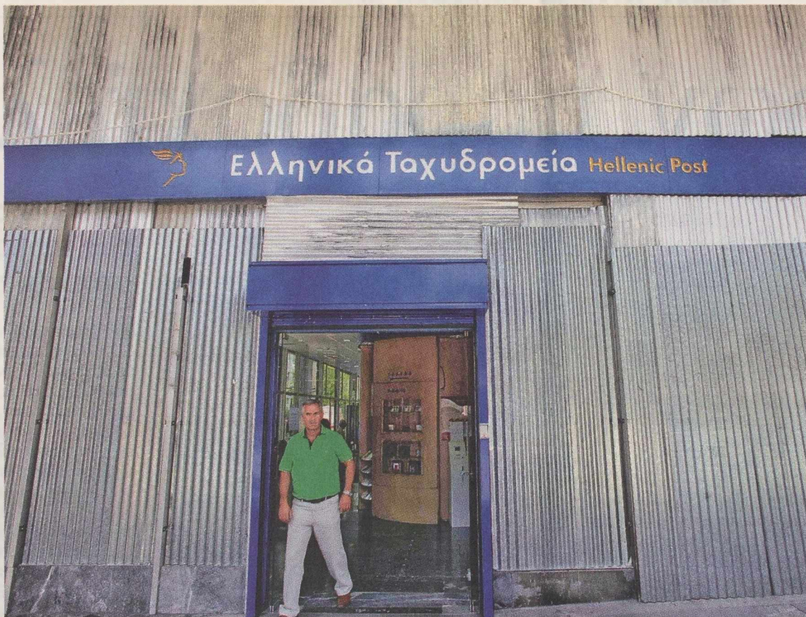
Η πρόσοψη των ΕΛΤΑ της πλατείας Συντάγματος καλύφθηκε με λαμαρίνες, λόγω της ανακαίνισης του ταχυδρομείου, που είχε πουληθεί στις διαδηλώσεις για το Μεσοπρόθεσμο. Πάντως, καλού-κακού εν όψει αποκρατικοποιήσεων και αναταραχών, οι λαμαρίνες εξυπηρετούν και ως θωράκιση...
