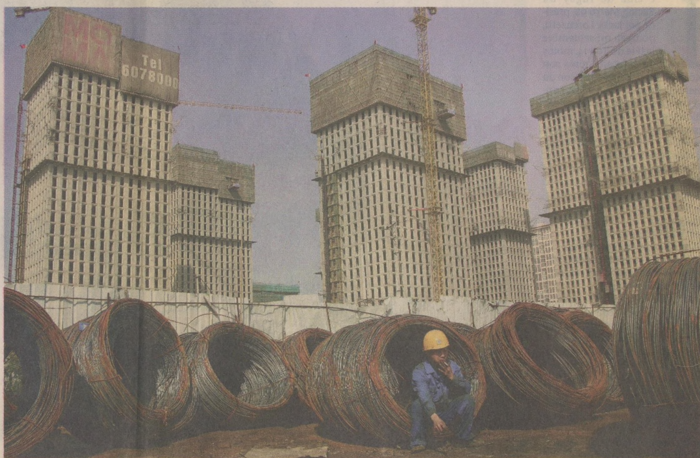
Construction d'immeubles à Taiyuan (Shanxi). En Chine, l'offre de logements est devenue pléthorique. REUTERS
