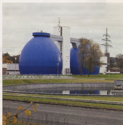
Kläranlage des Abwasserzweckverbands Mariatal,
