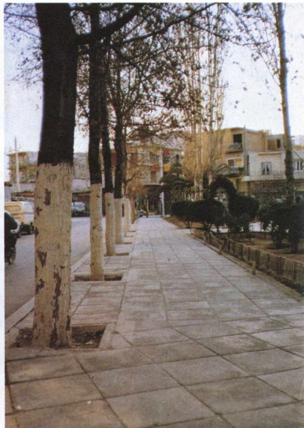
Από τα έργα των οδών Χίου και Δωδεκανήσου στα Καμίνια, με πλακοστρώσεις, πεζοδρόμιο, παρτέρια κ.ά.
