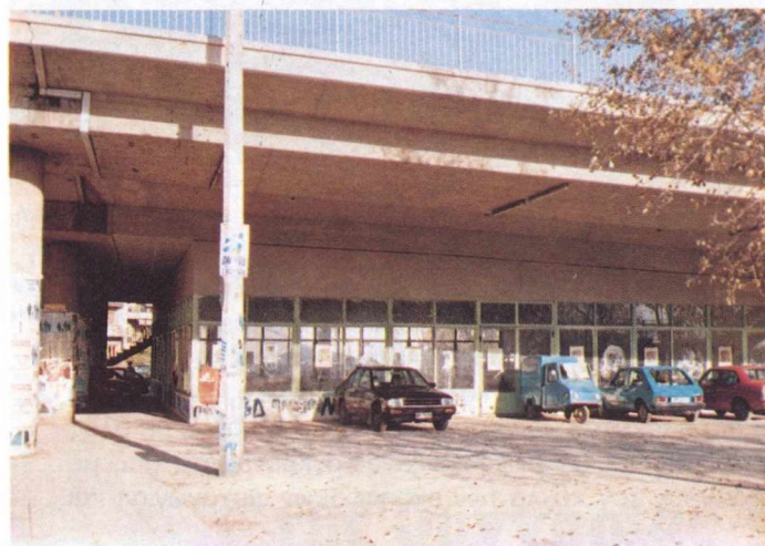
– Το Στέκι Νεολαίας που κατασκευάζεται στο Ν. Φάληρο.
