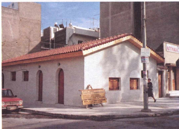
– Το κέντρο νεότητας που κατασκευάζεται στα παλιά Λουτρά Κλεισούβης.
