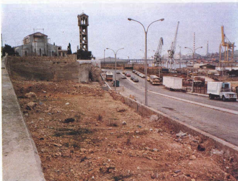
– Κατασκευή νέου γηπέδου μπάσκετ στο χώρο που βρίσκεται πλάι στη Ζωοδόχο Πηγή.
