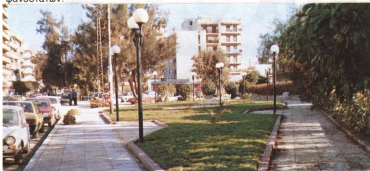
- Στην οδό Γιαννοπούλου, Ν. Φάληρο. Πλακοστρώση, διαμόρφωση κηπάριου.
