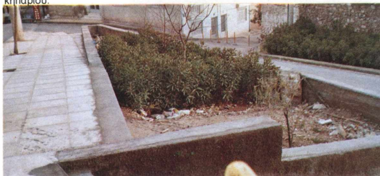
Κατασκευή κηπάριου στη διασταύρωση των οδών Φ. Κορυτσάς και Μακεδονίας (Πίσω από του Δηλαβέρη). Διαμόρφωση του χώρου με κλίμακες, καλλωπιστικά φυτά κ.ά.
