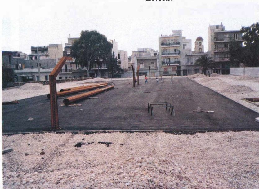
– «ΘΕΜΙΣΤΟΚΛΕΙΟ» Γυμναστήριο. Από τα έργα ανακατασκευής.
