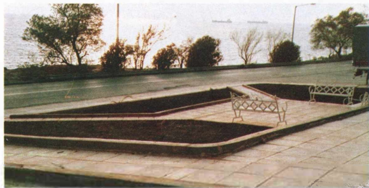
- Ακτή Θεμιστοκλέους. Πλακοστρώση, διαμόρφωση χώρου αναψυχής με γκαζόν, δένδρα, νέα παγκάκια.
